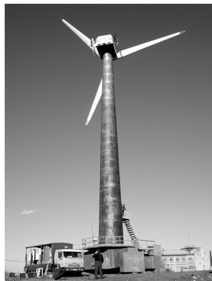
Рисунок 1 – Полевые испытания многофункционального энерготехнологического комплекса на базе ветроэлектростанции «Заполярная» и всережимного двигатель-генератора
