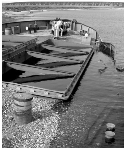
Рисунок 8 – Дефекты посадки корпуса лихтера на грунт
