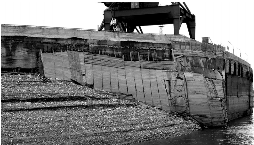
Рисунок 2 – Верховой открылок причала Олекминского речного порта с противоледовой защитой
