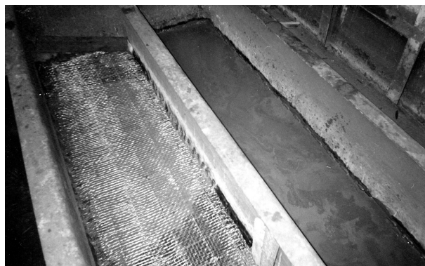
Рисунок 2 – Создание днищевое подкрепления в корпусе лихтера
