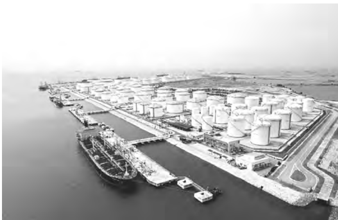
Рисунок 1 – РВС на нефтеналивном терминале
