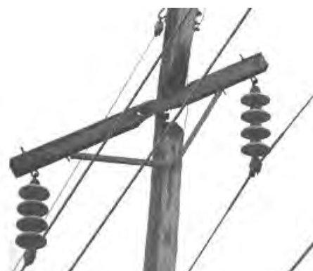
Рисунок 2 – Возгорание деревянных траверс и опор из-за токов утечки
