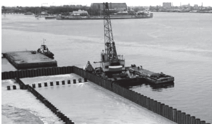
Рисунок – Комбинированная шпунтовая стенка причала строителей ФК «Зенит» ОАО «Газпром»
