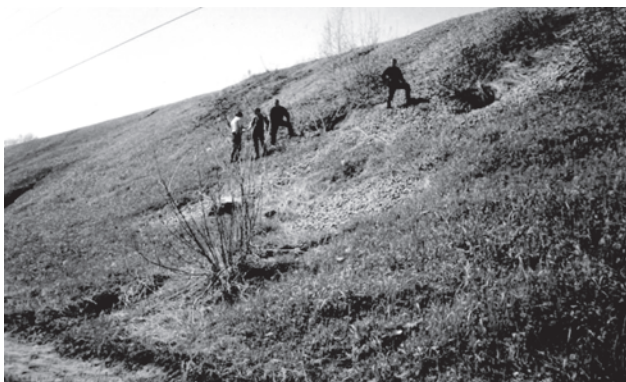
Рисунок 4 – Общий вид насыпи на 88-м км линии Алтайская-Бийск
