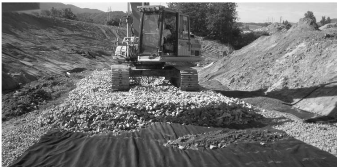
Рисунок 2 – Автоматизированная укладка слоя гранулированного пеностекла в обойму из геотекстиля [5]
