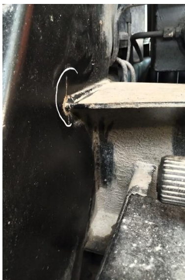
Рисунок 1 – Дефект опорной рамы – трещина по сварному шву с переходом на основной металл
